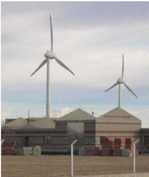
Generadores eólicos en Santa Cruz Foto: Archivo
